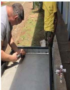
1.Imperméabilisation du bac par silicone
