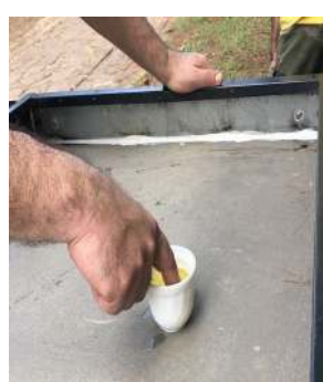
1.Imperméabilisation du bac par silicone
