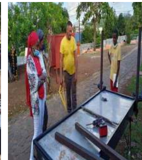
3.Fixation des pieds sur le caisson.
